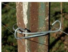
**„Selbsthaltende Feder“:** wird mit einer speziellen „Zange“ von der Oberkante der Beton- oder Holzsäule auf die richtige Position nach unten hin geschoben. Kostengünstig. Sie ist für jedes Maß an Mittelsäulen erhältlich.
